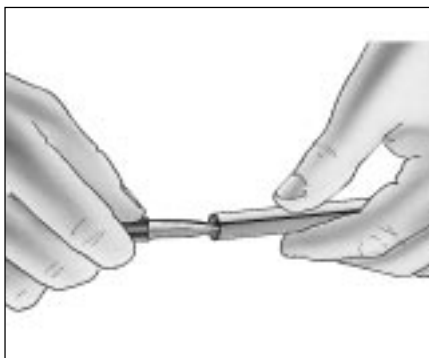
Entgraten des Kupferrohres
